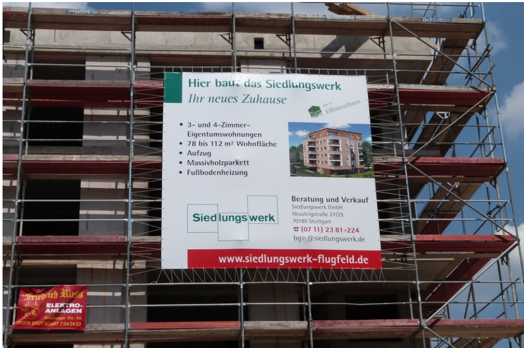
Blockout-Plane 500 x 500 cm mit Gummiseilen am Baugerüst gespannt
