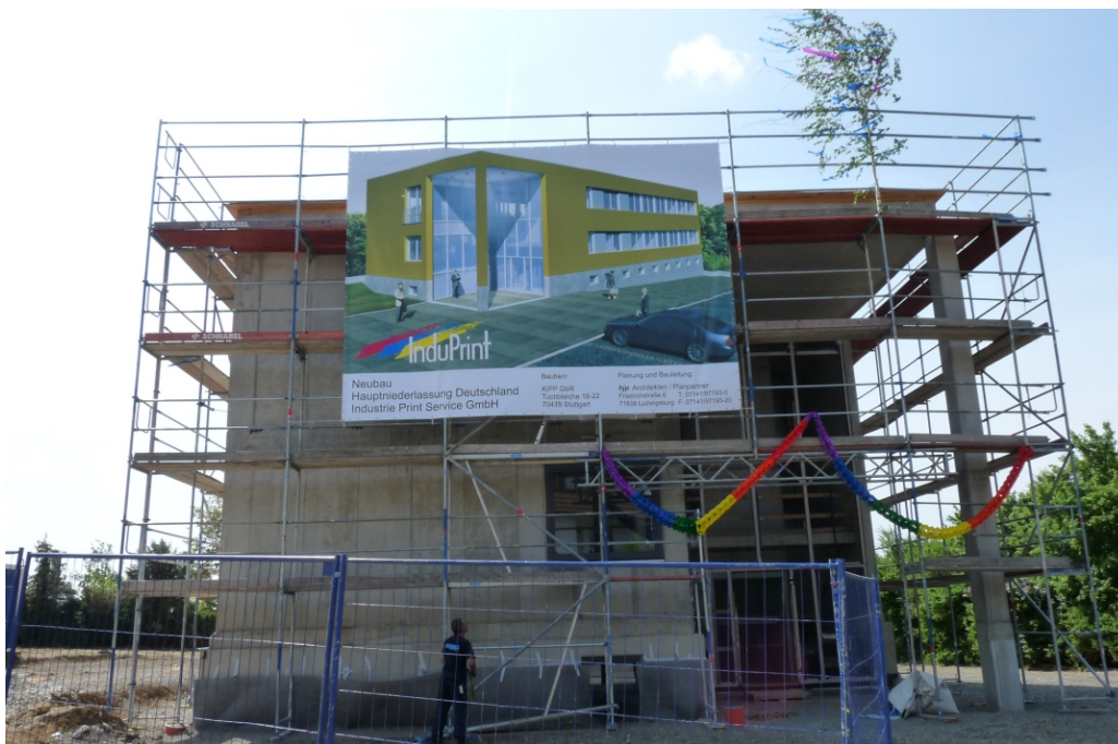
zum Richtfest provisorische Verspannung einer Plane mithilfe von Kabelbindern
