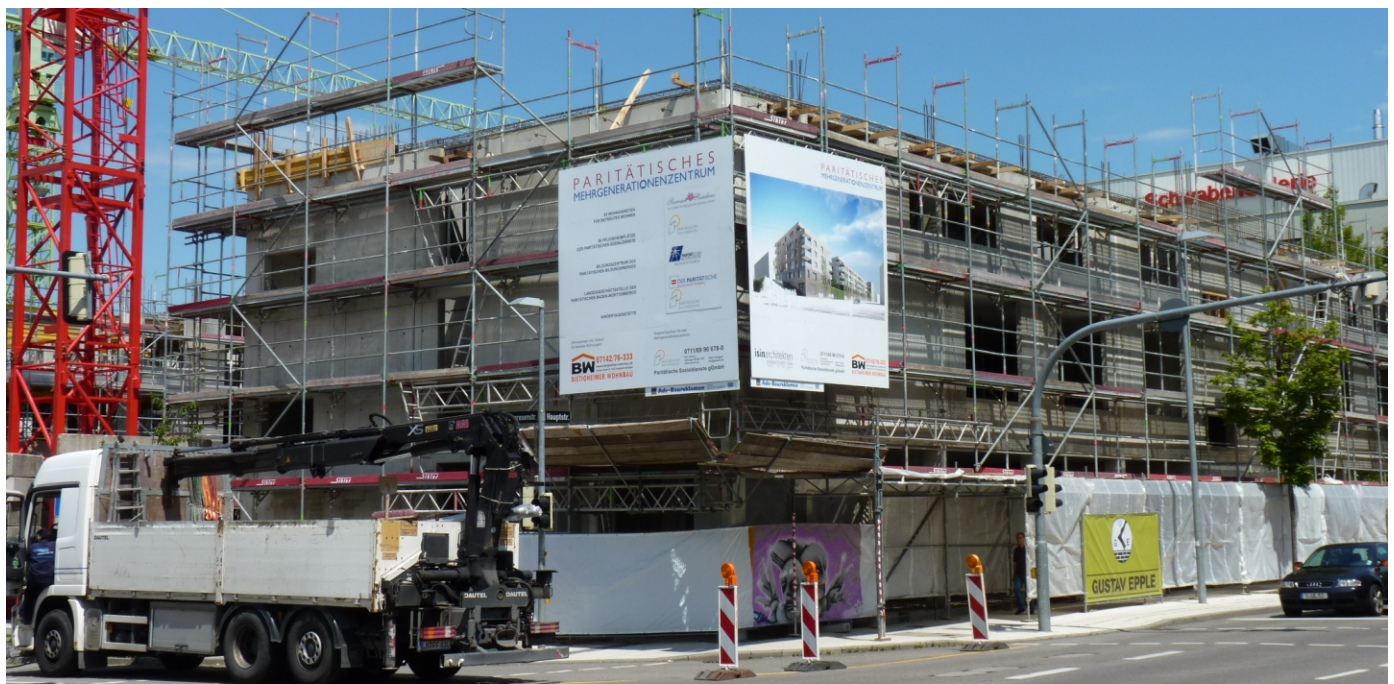
Alu-Gitterträger-Konstruktion mit jeweils 400 x 400 cm großen Schildern über Eck montiert an die Baugerüste
