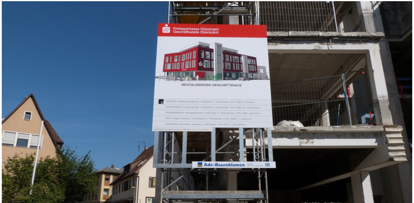
Alu-Gitterträger-Konstruktion mit Erweiterung für Firmen, montiert an das Gerüst der Fassade
