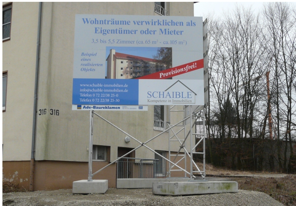
Alu-Dreieckskonstruktion mit jeweils 300 x 300 cm großen Schildern auf vorbereitetem, befestigten Untergrund aufgestellt
