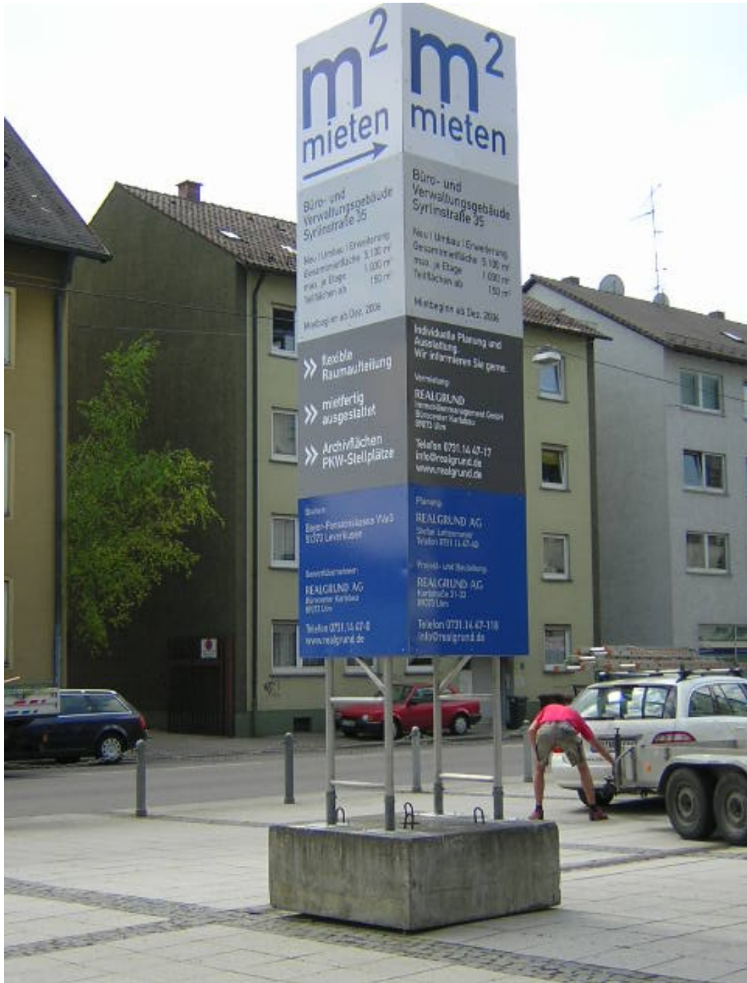
Werbeturm auf Alu-Gitterträger-Konstruktion vierseitig sichtbar - je Seite 100 x 400 cm
